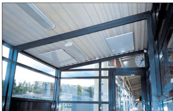
Потолочная установка приборов автоматически защищает их от несанкционированного контакта.
