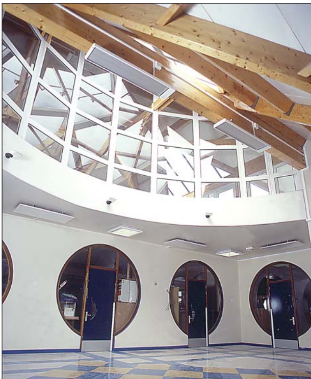
Кассеты НР обеспечивают комфорт в тех частях здания, где ниже потолки. В остальных –обогрев обеспечивается обогревателями EZF (см. стр. 28-35).
