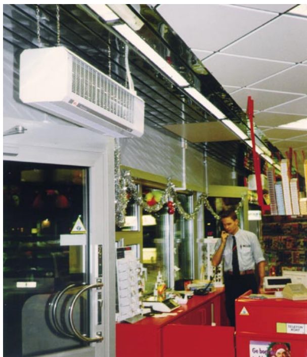
Крепление к потолку на стержнях
