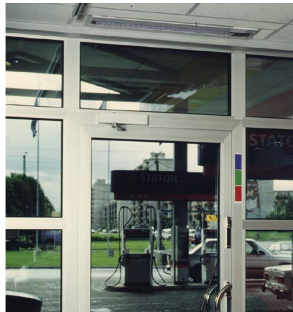
Установка в подвесной потолок
